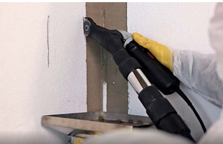
Der Fliesencarver eignet sich zum Bearbeiten von Ecken, Winkeln und Kanten sowie zum Einschneiden von Fliesenfugen
