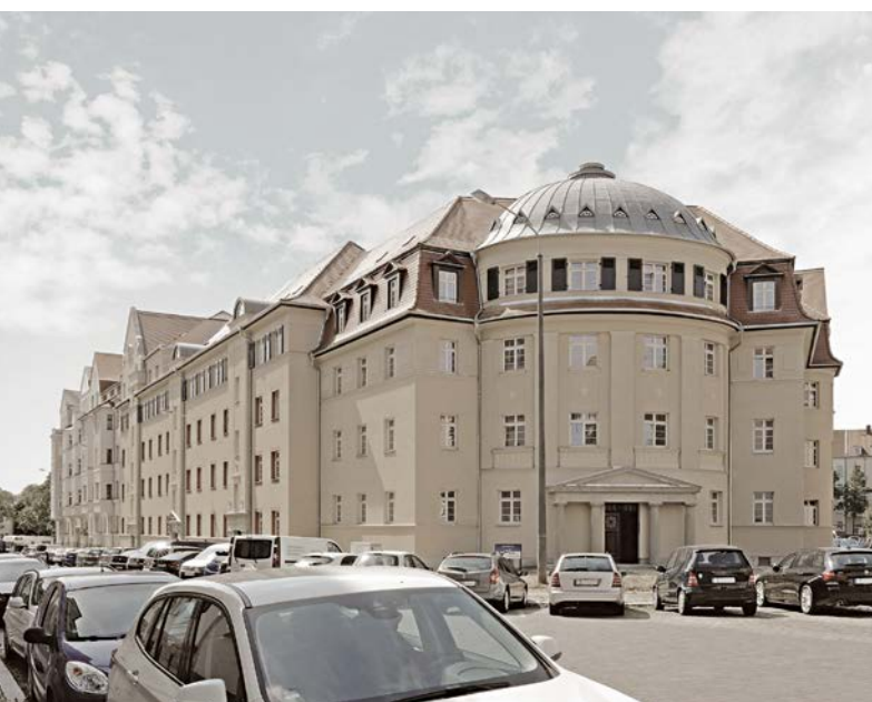
Eine Seltenheit im genossenschaftlichen Wohnungsbau: das Eingangsportale der Renkwitzstraße 12, im zu Ehren seines Erbauers „Riemann Quartier“ genannten Ensemble
