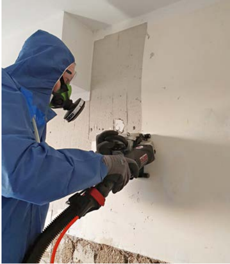
Die handgesteuerte Fräse lässt sich mit einem Aufsatz unterschiedlichen Untergründen anpassen
