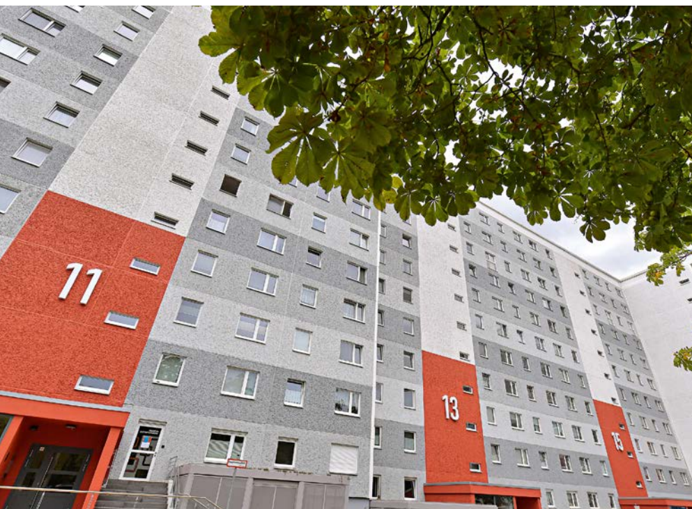
Mit dem Projekt „Smartes Quartier Jena-Lobeda“ in der Ziesegarstraße sammelte die Jenawohnen Erfahrungen, auf die das Projekt „JenErgieReal“ aufbauen kann
