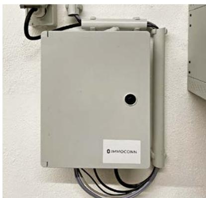
Das IoT-Gateway zur digitalen Heizungsüberwachung befindet sich in einer Box, die im Heizungskeller montiert wird. Die erhobenen Daten werden in einer Cloud gespeichert
