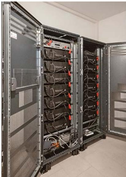
Ein Batteriespeicher mit einer Kapazität von 67 kWh versorgt die Wohnungen von zwei Gebäuden mit Energie
