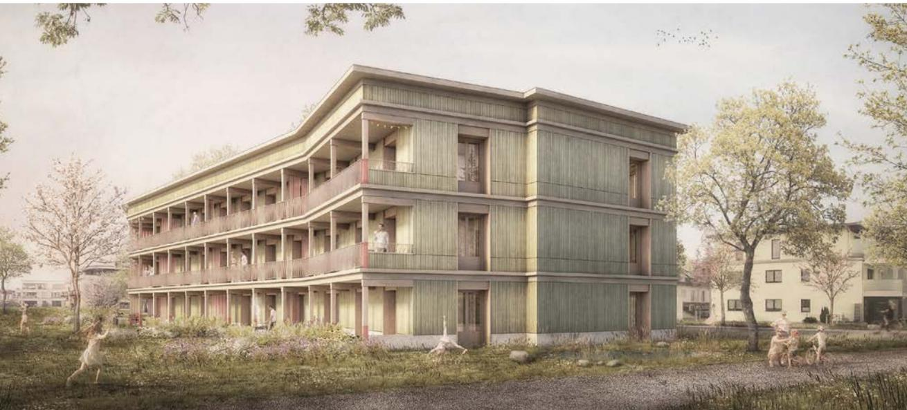
Beim „Haus fast ohne Heizung“ der GWG Ingolstadt wird möglichst auf Verbundwerkstoffe verzichtet und auf die Verwendung sortenrein zurückbaubarer Materialien geachtet. Die Ziegel-Außenwände bekleidet eine Holzverschalung und statt die Stahlbetonwände und -decken in den Wohnungen und Treppenhäusern zu verspachteln, erhalten sie einen lasierenden Anstrich
