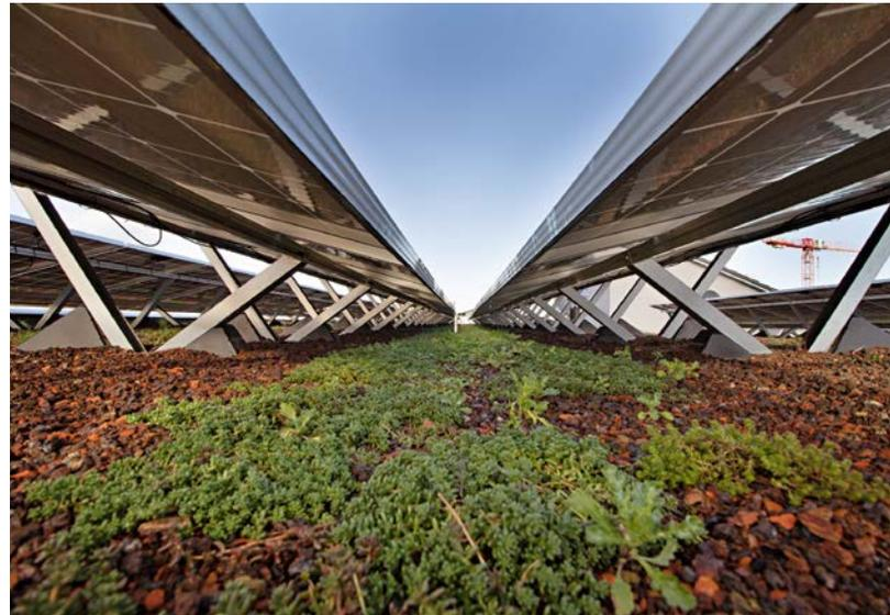
Eine spezielle Unterkonstruktion der PV-Anlagen erlaubt die Kombination mit einer Dachbegrünung
