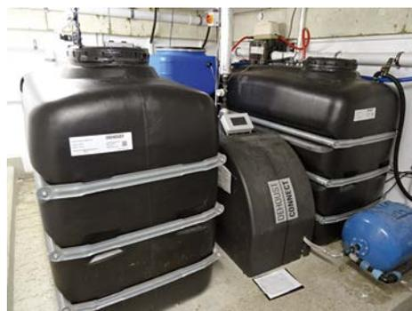
In der Grauwasser-Aufbereitungsanlage werden gering verschmutzte Abwässer aus dem Badezimmer gefiltert, biologisch gereinigt und für die Toilettenspülung verwendet
