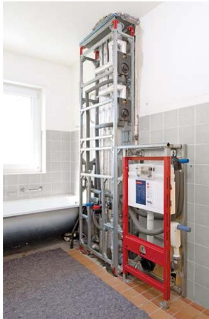
Dank vorgefertigter Register konnten die Bäder strangweise brandschutzkonform saniert werden
