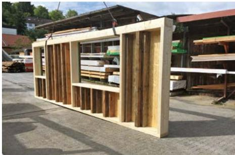
Eine vorgefertigte Holzbauwand wartet auf ihre Montage. Sie entstand unter Wiederverwendung von Holzbalken aus NHW-Rückbauten
