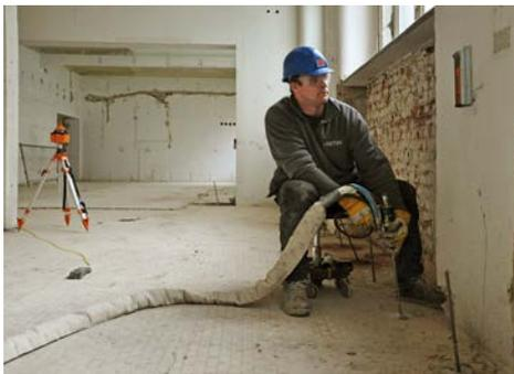
Die Injektionen erfolgen über eine spezielle Injektionspistole – im Hintergrund der Rotationslaser für die messtechnische Überwachung
