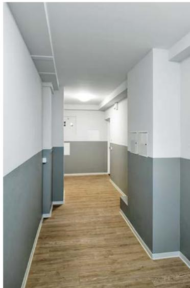
Die industriell vorgefertigten Installationsschächte konnten außerhalb der Wohnungen platziert werden (siehe Bild links), da die Bäder zum Flur hin liegen. Anschließend (siehe Bild rechts) erfolgte die Beplankung und die Verkleidung, sodass im Flur ein harmonisches Gesamtbild entsteht
