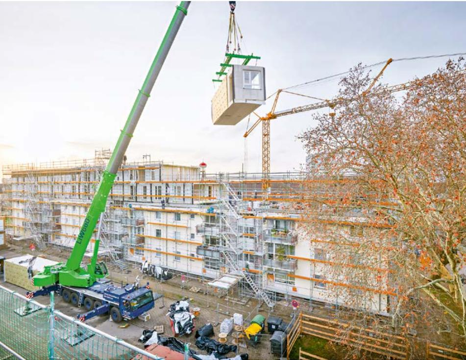
Mit Holzrahmenbaummodulen wurden die bestehenden Gebäudezeilen aufgestockt. Trotz des vergleichsweise geringen Gewichts der Module, musste die Ablastung im Boden mittels eines speziellen Injektionsverfahrens verbessert werden
