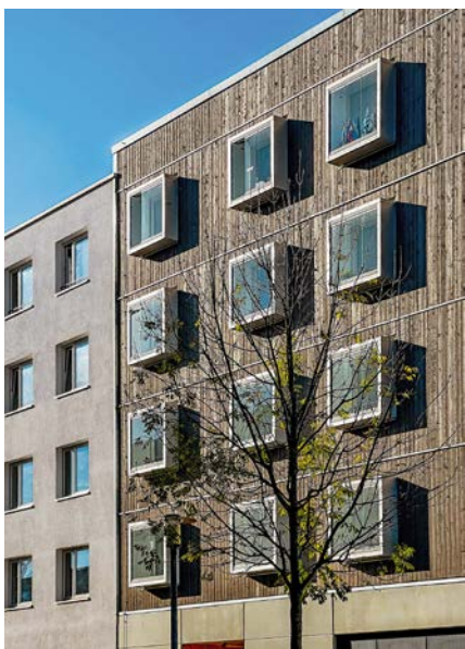
In München-Riem sorgen Kastenfenster für einen verbesserten Schall- und Wärmeschutz
