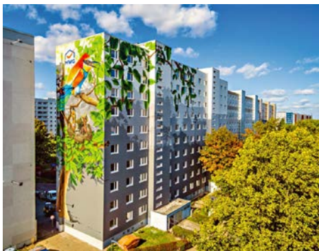
Die MWG zog den P2-Plattenbau in Magdeburg-Kannenstieg komplett leer, um Grundrisse verändern und neue Wohnungstypen anbieten zu können. Das Projekt wurde mit 800.000 € gefördert
