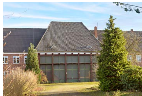
Die „Ehrenhalle“ wird umgebaut und künftig als Quartierstreff dienen. Ein denkmalgeschütztes Mosaik aus der NS-Zeit wird dabei verdeckt
