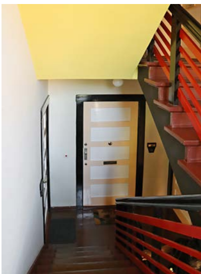
Farbig sind in der Schillerpark-Siedlung nicht die Fassaden, dafür aber die Treppenhäuser
