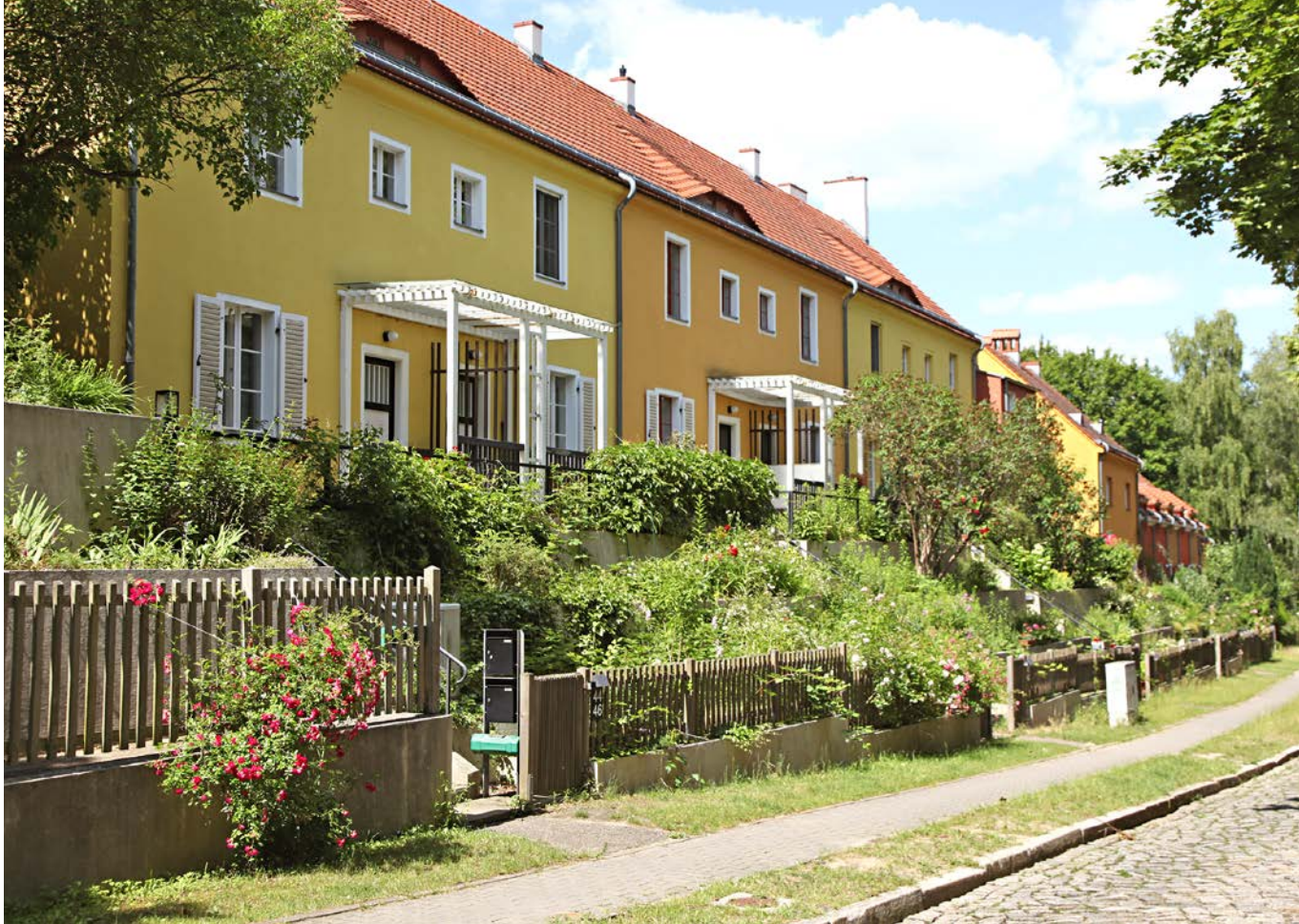
Reihenhäuser im Gartenstadtweg in der Gartenstadt Falkenberg. Charakteristisch ist die Farbigkeit der Siedlung
