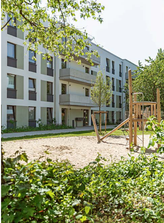
Bei der Saga in Hamburg sind Neubauten hinsichtlich der Ausstattung stark standardisiert. Basis dafür sind die förderrechtlichen Standards der Hamburger Investitions- und Förderbank
