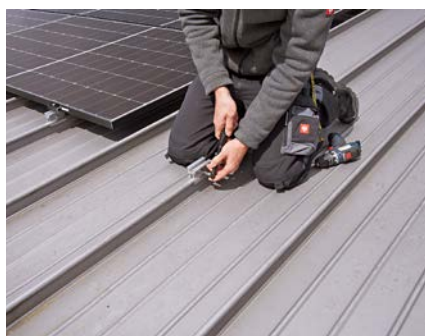
In wenigen Schritten lässt sich das PV-System schnell und einfach an den vorhandenen Stehfalzprofilen befestigen
