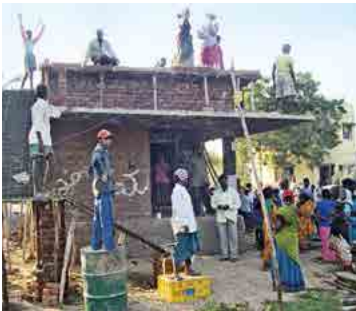
Hausbauprojekt Vetapalem, Indien: Hilfe zur Selbsthilfe ist ein Prinzip in allen DESWOS-Projekten. Die Eigenleistung der Menschen hilft die Baukosten zu senken
