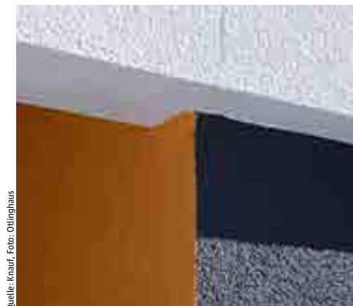
Scheibenputz-Struktur und ebene Übergänge mithilfe dickerer mineralischer Putzsysteme
