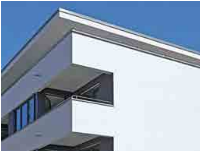
Das PU-WDVS wurde auch über Kopf unter dem Dachüberstand verarbeitet
