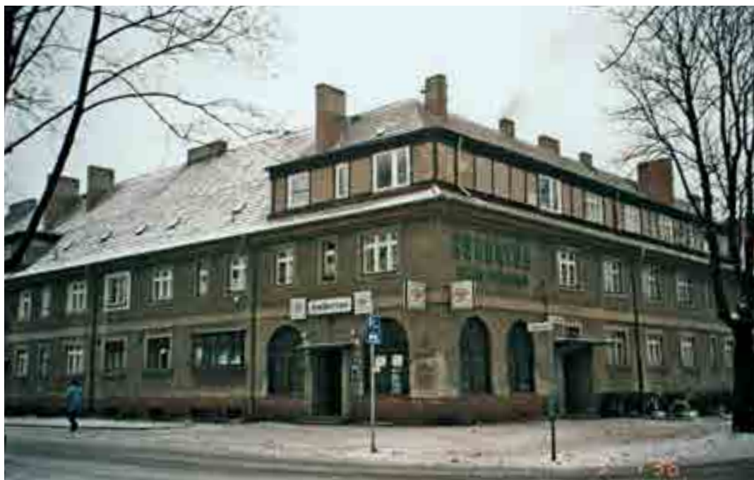
Einen plastischen Eindruck von der Größe der Herausforderungen in der Wendezeit vermitteln Vorher-Nachher-Bilder. Ein Beispiel ist dieses stadtbildprägende Ensemble der Wohnungsgenossenschaft „Einheit“ Hennigsdorf eG an der Jägerstraße im zentrumsnah gelegenen Wohngebiet Mitte. Die Bauten aus den 1920er Jahren wurden bis Ende der 1990er Jahre grundlegend modernisiert ...
