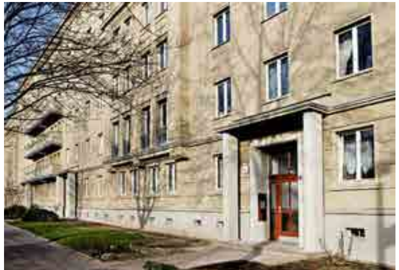
Der Wohnpalast nach der aufwändigen Sanierung: nur beim genauen Hinsehen bemerkt man die unterschiedlichen zeitgenössischen Beige- und Brauntöne sowie Materialien
