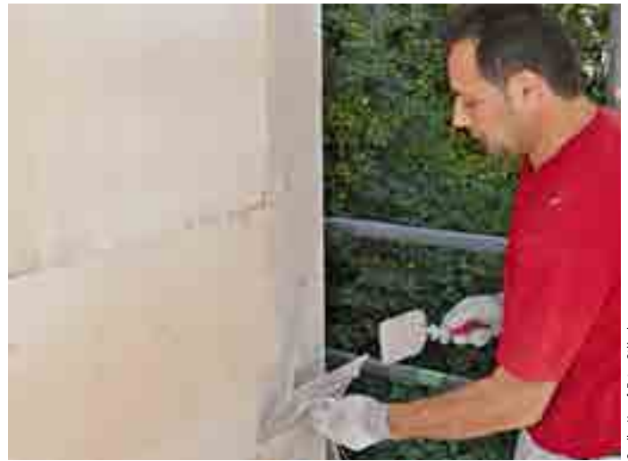
Ansetzen der Kantenprofile für dickschichtige mineralische Putze
