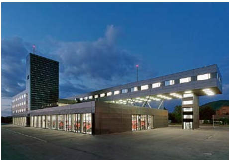
Womit alles begann: Der Bau einer neuen Feuerwache im Jahr 2007 war der Startschuss für den Wandel der GGH zur Immobiliendienstleisterin
