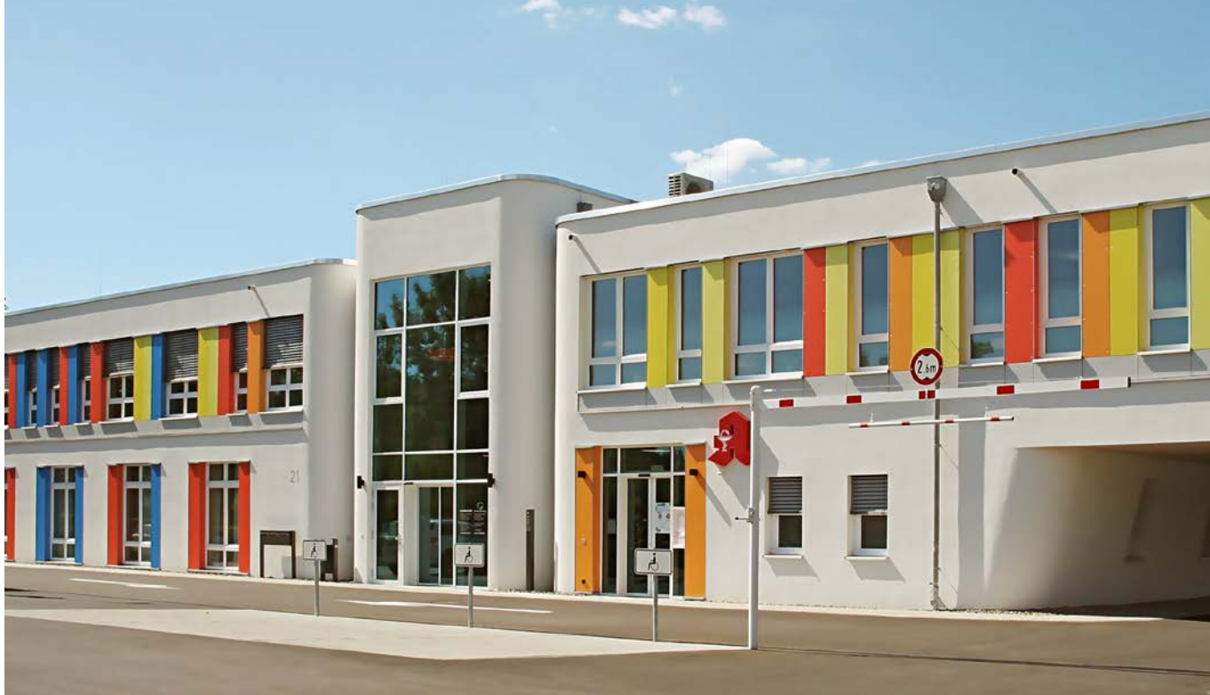
Das vom Büro Format4pro geplante Gesundheitszentrum in Memmelsdorf beherbergt eine allgemeinmedizinische Gemeinschaftspraxis, eine Hebammenpraxis, eine Apotheke und eine Bankfiliale. Dank eines gesundheitlichen Qualitätsmanagements während der Bauphase erfreuen sich Mitarbeitende und Patienten einer geprüft gesünderen Raumluft
