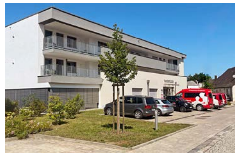
Der Pflegestützpunkt in Markt Burgebrach bietet Raum für eine Tagespflegeeinrichtung und acht Seniorenwohnungen
