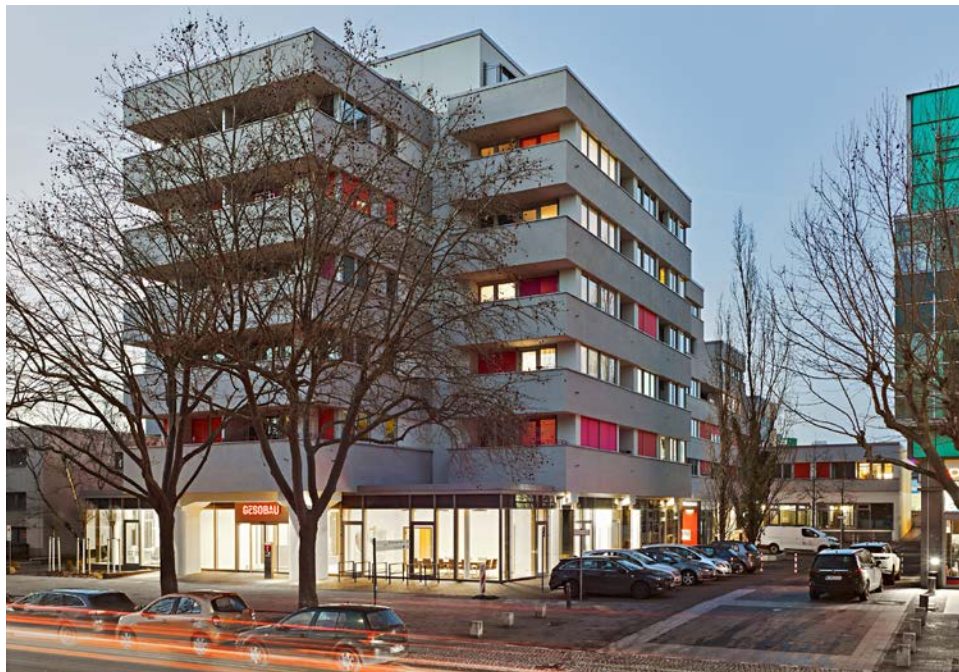
Die Büros ihres ehemaligen Verwaltungsgebäudes im Wilhelmsruher Damm baute die Gesobau zu Seniorenwohnungen um, im Erdgeschoss richtete sie ein Kundenzentrum ein
