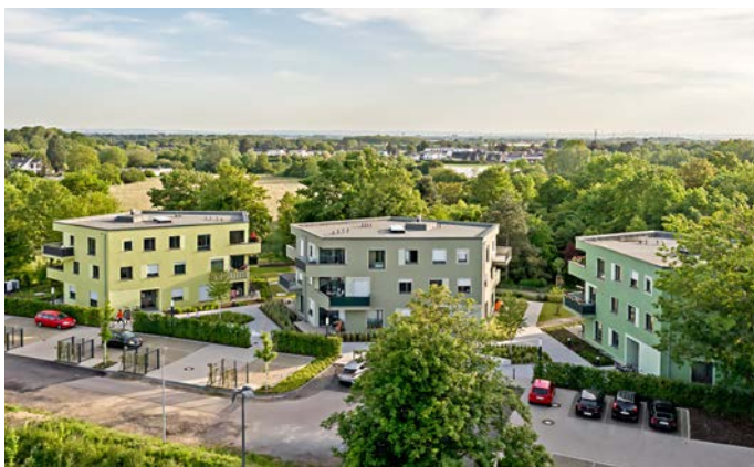
Kein gewöhnlicher Bau einer Flüchtlingsunterkunft: Durch den Einsatz typisierter Gebäude und deren geschickter Anordnung wurden in Erfurt hohe Maßstäbe für den Bau von Wohnungen für Geflüchtete gesetzt
