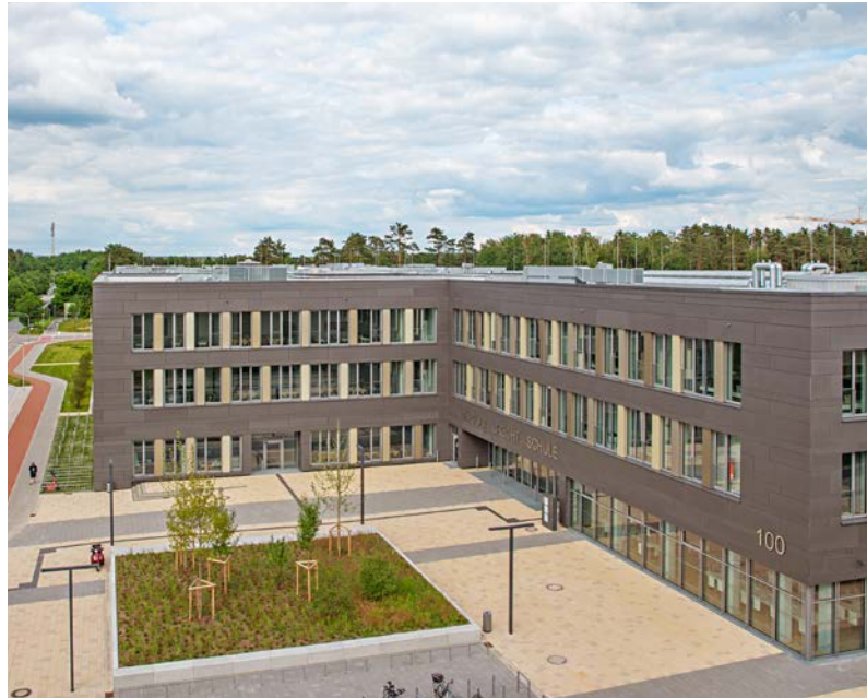
Eingangsbereich der Bertolt-Brecht-Schule: Das Schulzentrum umfasst eine Mittelschule, eine Realschule, ein Gymnasium und ein Abendgymnasium mit 1.800 Schülerinnen und Schülern am Tag und 800 am Abend
