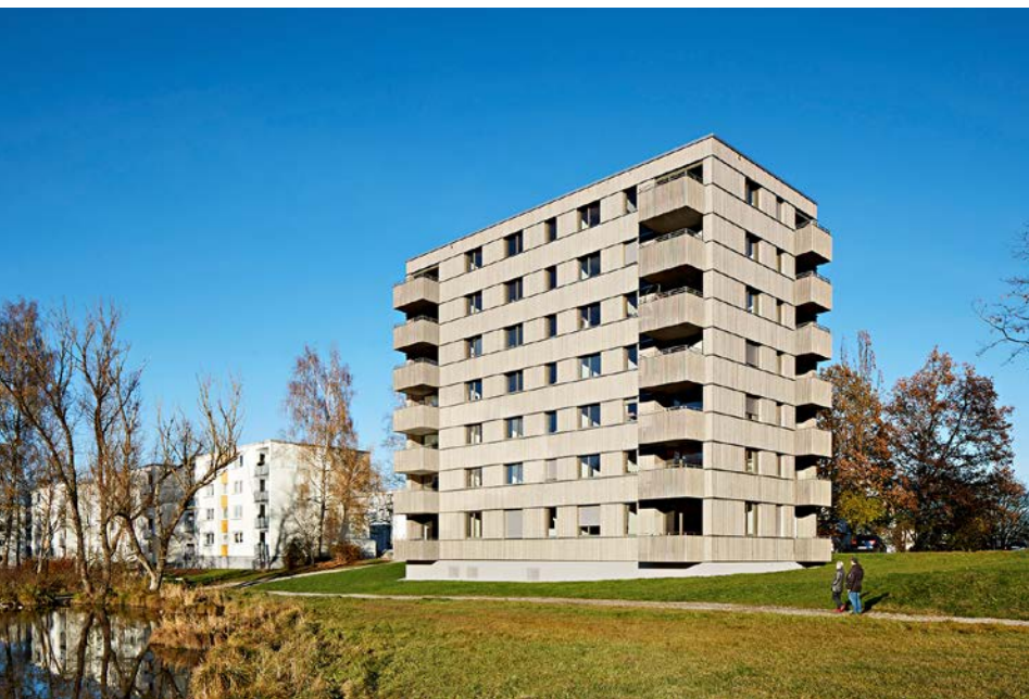
Ein Siebengeschosser nur aus Holz? Die Sozialbau Kempten zeigt mit ihrem „Wohnen am Weiher“ überzeugend wie es geht: mit viel Holz und einem innovativen Brandschutzkonzept
