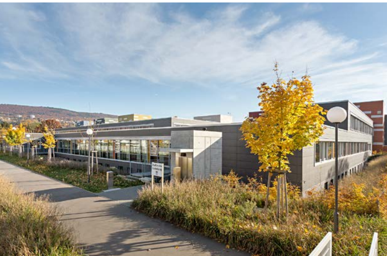
Die Internationale Gesamtschule Heidelberg (IGH), eine Ganztagschule in Heidelberg-Rohrbach, wurde im laufenden Betrieb von der BSG saniert
