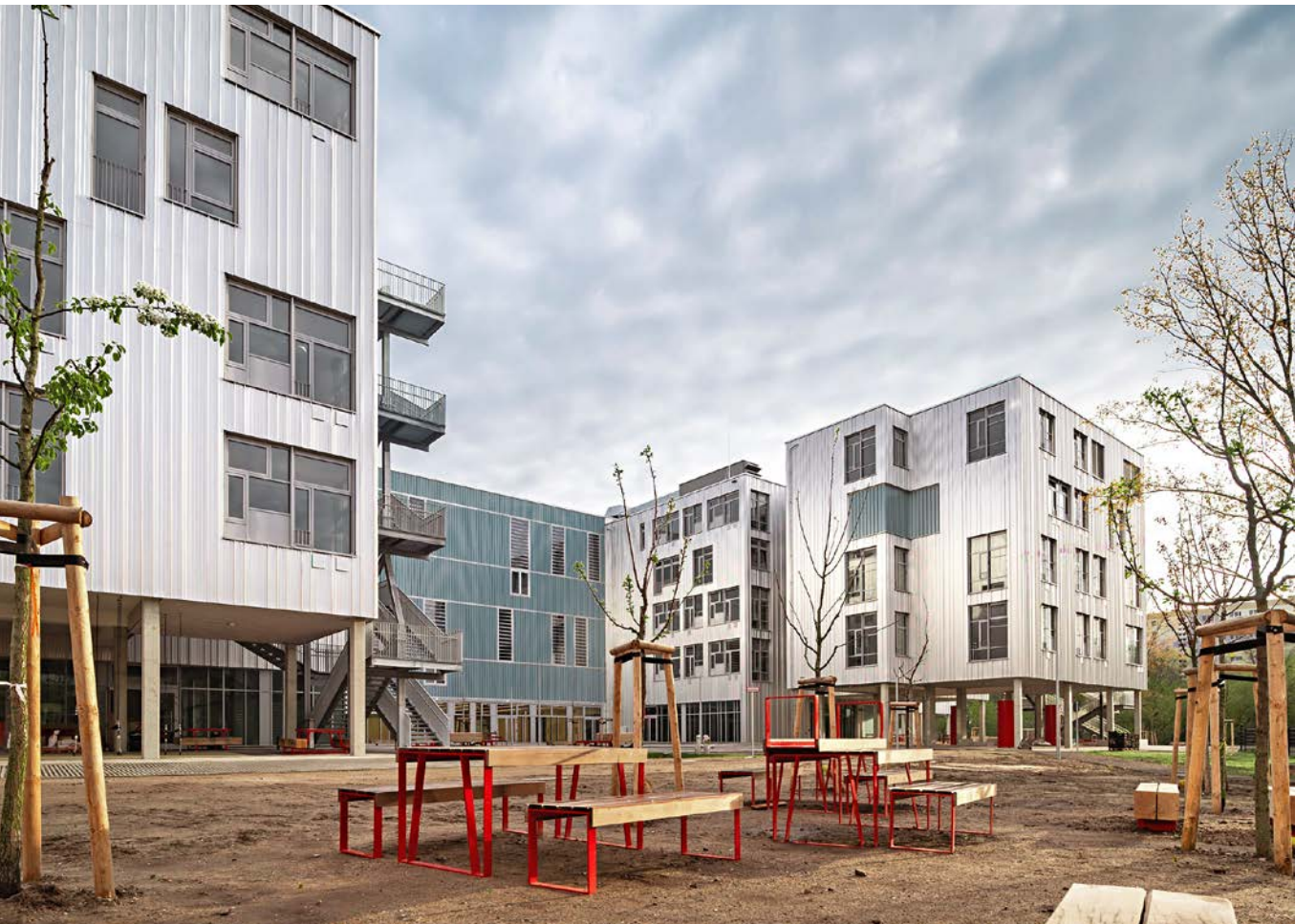
Der Neubau an der Allee der Kosmonauten in Berlin-Lichtenberg zeigt schon von außen die innere Organisation als Compartmentsschule mit flexiblen Einheiten
