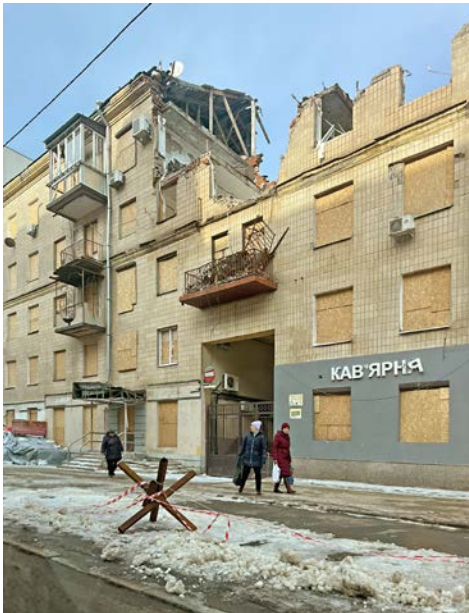
Teilerstörte Gebäude werden nach und nach wieder aufgebaut. Die Mittel dafür sind allerdings begrenzt
