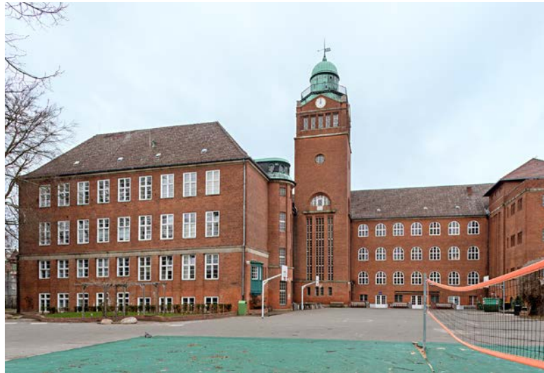
Die Sanierung der häufig unter Denkmalschutz stehenden Bestandsschulen stellt besondere Anforderungen, wie hier das 1905 und 1914 errichtete Schadow-Gymnasium in Berlin-Zehlendorf
