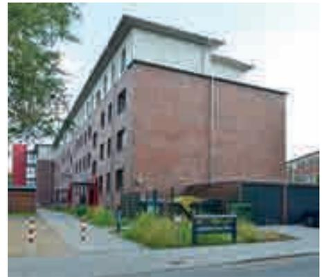
Oben: Die Materialität der sanierten Fassaden sollte weitestgehend dem ursprünglichen Gebäude entsprechen – zum Vergleich ein unsanierter Trakt rechts im Bild.
