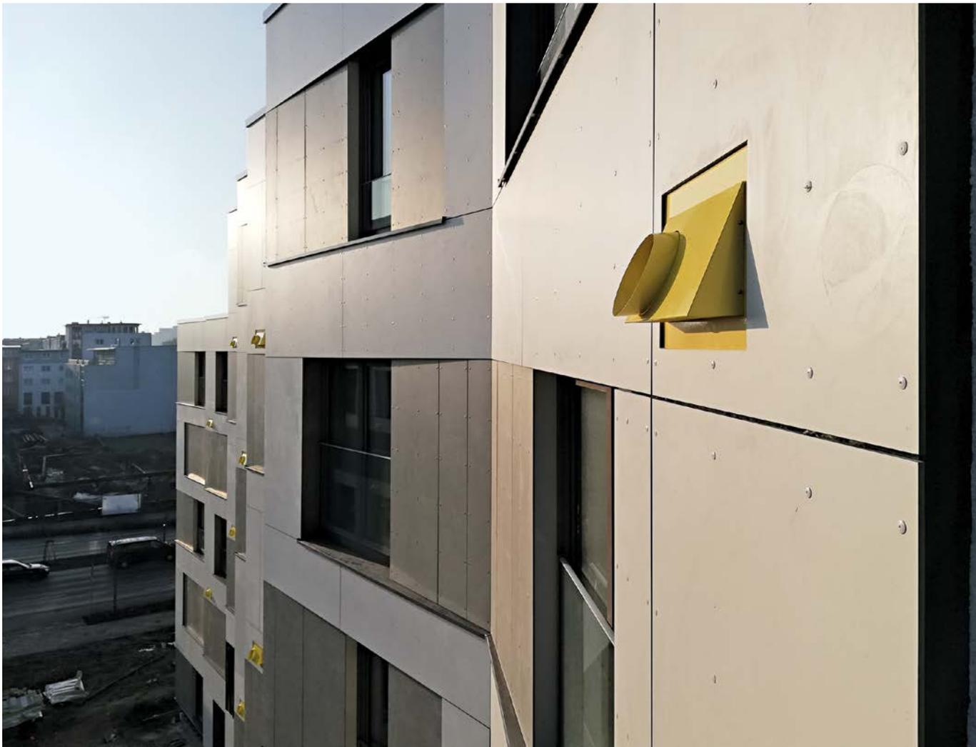
Die Auslässe von Lüftungsanlagen lassen sich mittels Sonderfarbe auch als Stilmittel einsetzen, wie hier beim „Studines“ in Rostock. Jedes der 76 Apartments für Studierende weist eine individuell steuerbare Lüftung auf
