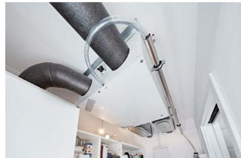
Schlanke Komfortlüftungsanlagen mit Wärme- und Feuchterückgewinnung passen in Nebenräumen oder im Flur unter die Decke
