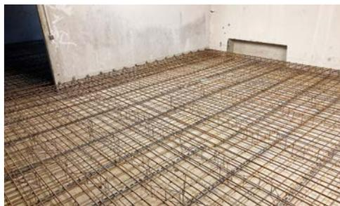
Das geringe Gewicht spricht für Aufstockungen mit Holz. Trotzdem musste das Fundament aufwendig verstärkt und im Keller eine zusätzliche Bodenplatte mit Stahlgeflecht aufgebaut werden
