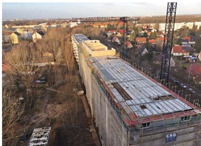
Das Drempegeschoss wurde vollständig entfernt, nur die letzte Geschossdecke blieb erhalten. Nach der Weiterführung der vorhandenen Medienstränge begann mit dem Stellen der Wände die eigentliche Aufstockung
