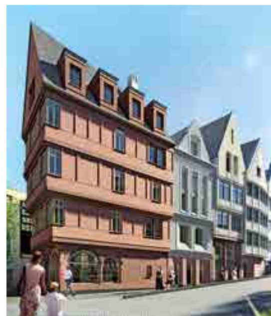
Nach Ansicht einiger Akteure hätten die Gebäude des historischen Krönungswegs originalgetreu rekonstruiert werden sollen
