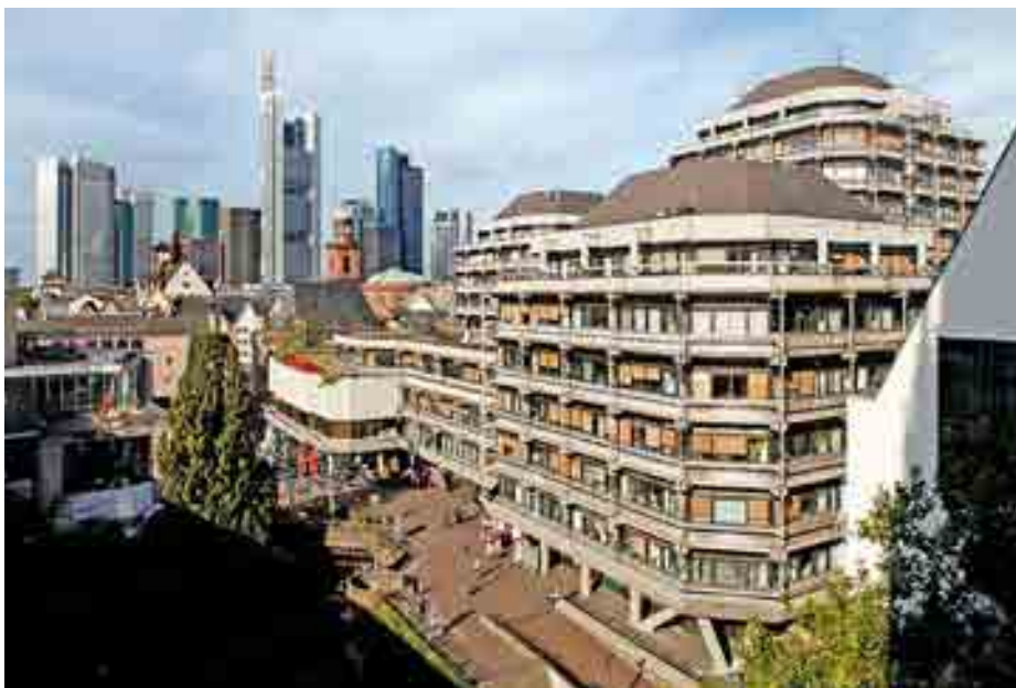
Das in den 1970er Jahren errichtete Technische Rathaus sprengte mit seiner monumentalen Gestalt das Umfeld. Nach seinem Abriss wurde unter dem Areal ein riesiges Parkhaus gebaut - und darauf die neue alte Stadt
