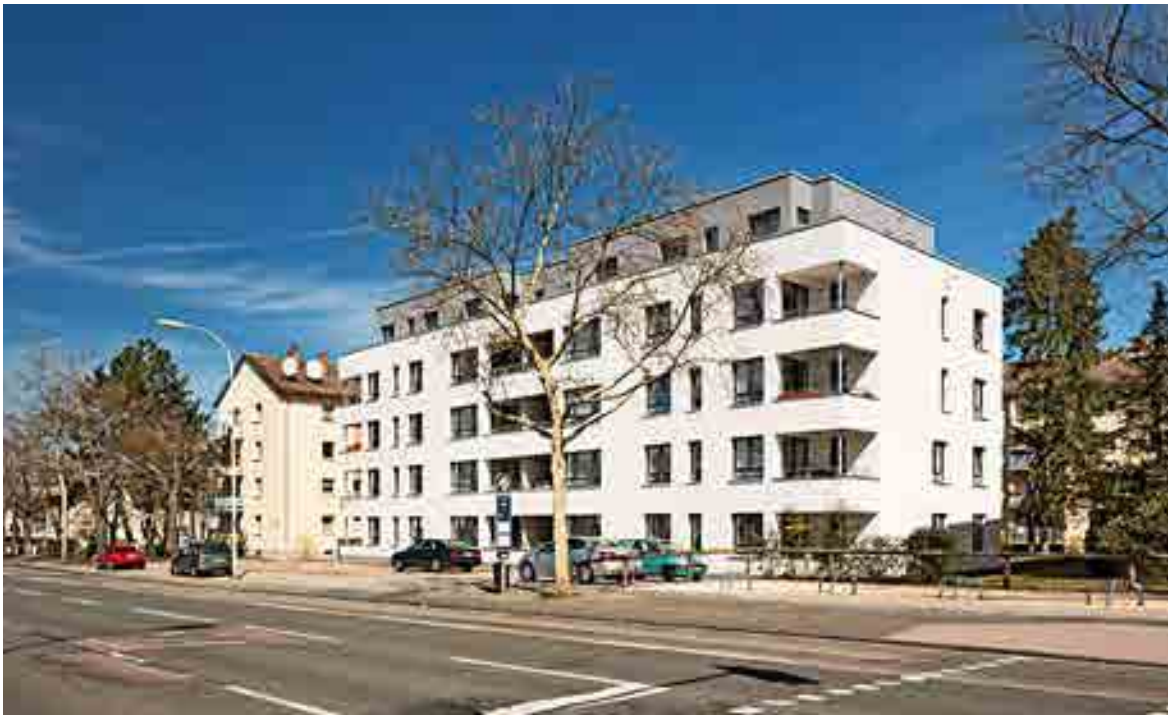
Sozialwohnungsbau der Bauverein AG in der Rüdeshheimer Straße in Darmstadt
