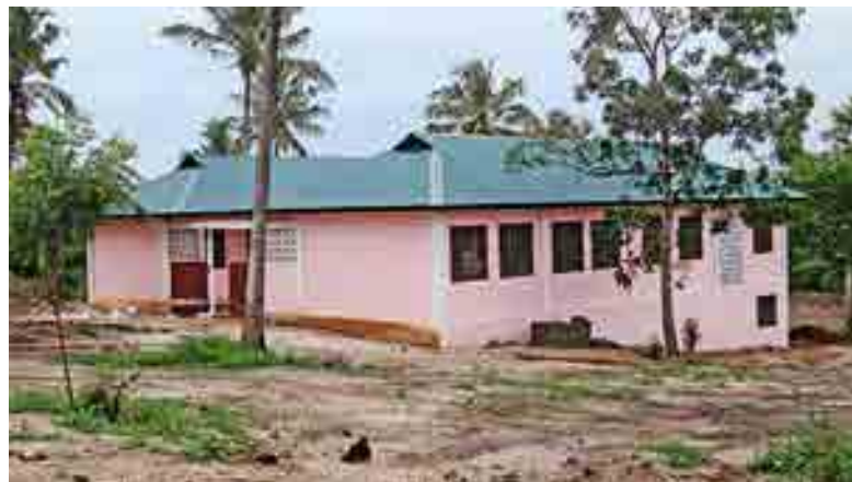
Das neue Wohnheim für die Mädchen kurz nach der Fertigstellung im Jahr 2013
