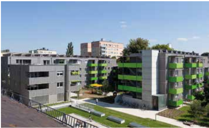
Nachverdichtung: Die parallel angeordneten Zeilen ermöglichten eine Aufstockung ohne dem Nachbarn die Sonnen zu nehmen.
