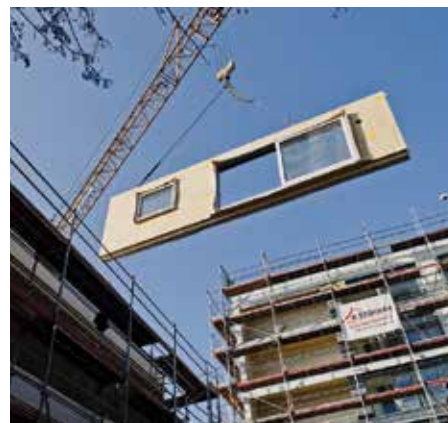
Anlieferung und Montage der Fassadenelemente
