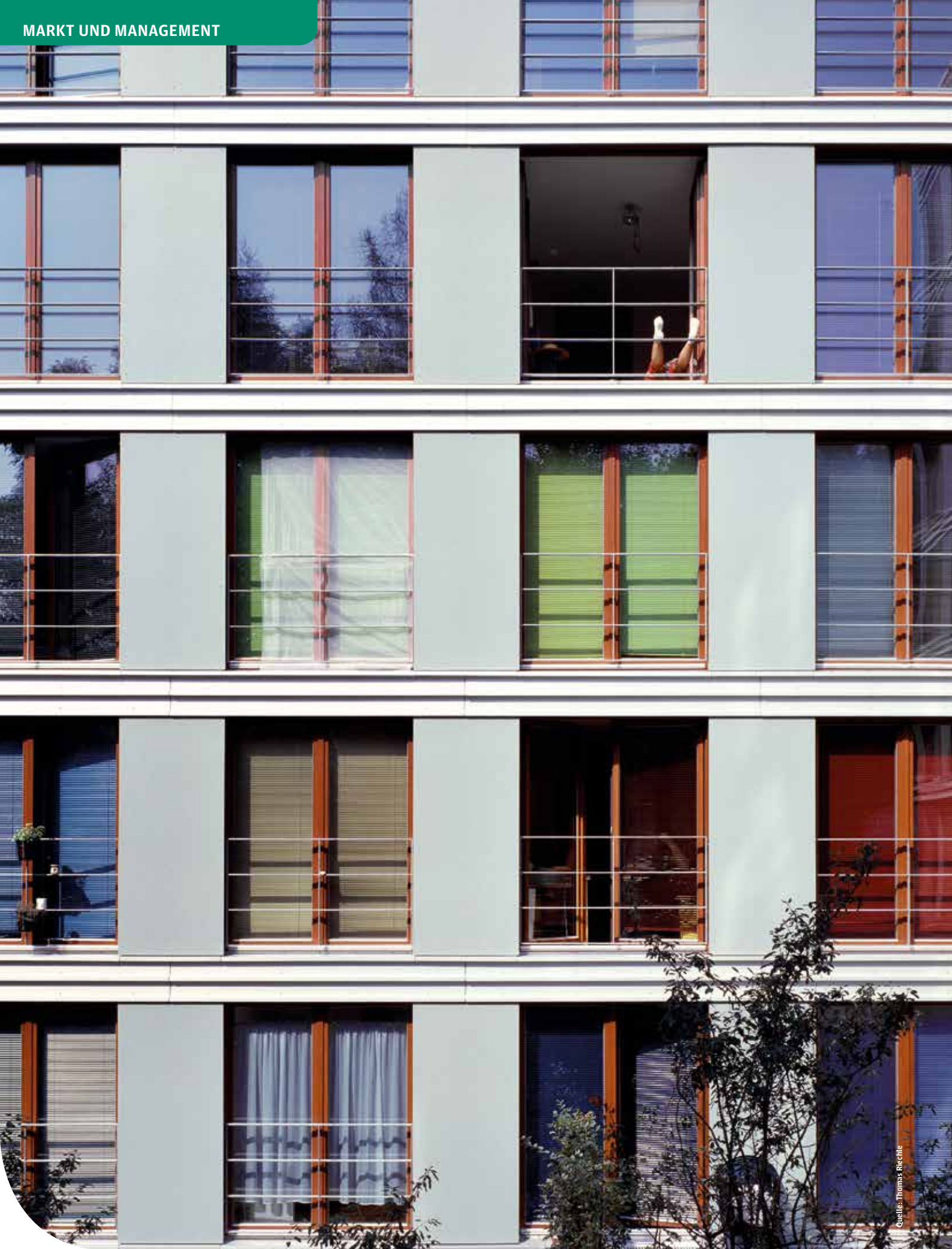
Detailansicht der „Neuen Bourse“, die vor gut zehn Jahren mit Holztafelelementen eine Faassadesanierung erhielt.
