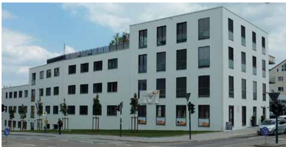
Das Wohn- und Geschäftshaus in Regensburg: Neubau nach Muster-Holzbaurichtlinie mit Übereinstimmungsnachweis
