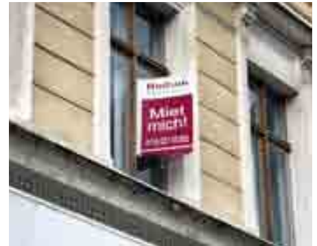
In der Gölitzer Innenstadt stehen viele sanierte Gründerzeitwohnungen leer.
