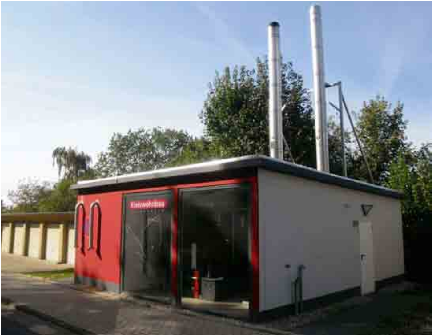
Das bungalowähnliche Heizhaus des Heizwerks Giebelstieg.
