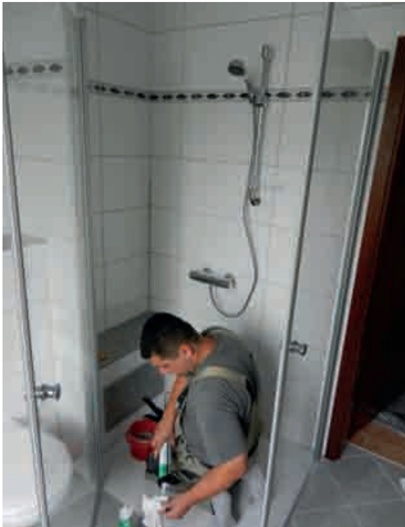
Monteur beim Einbau der barrierefreien Dusche „Easygo Plus“ in Buxtehude. Die Pumpe ist in der Sitzbank versteckt.
