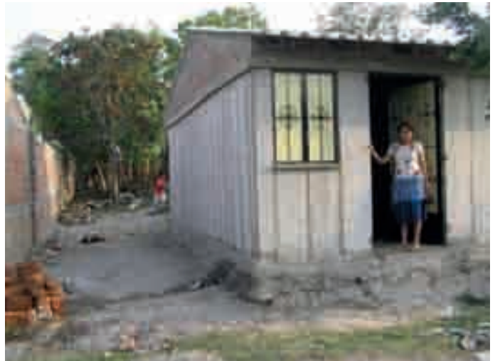
Stolze Besitzerin vor ihrem neuen Haus – die Wandfertigteile und Dachziegel wurden vor Ort hergestellt.
