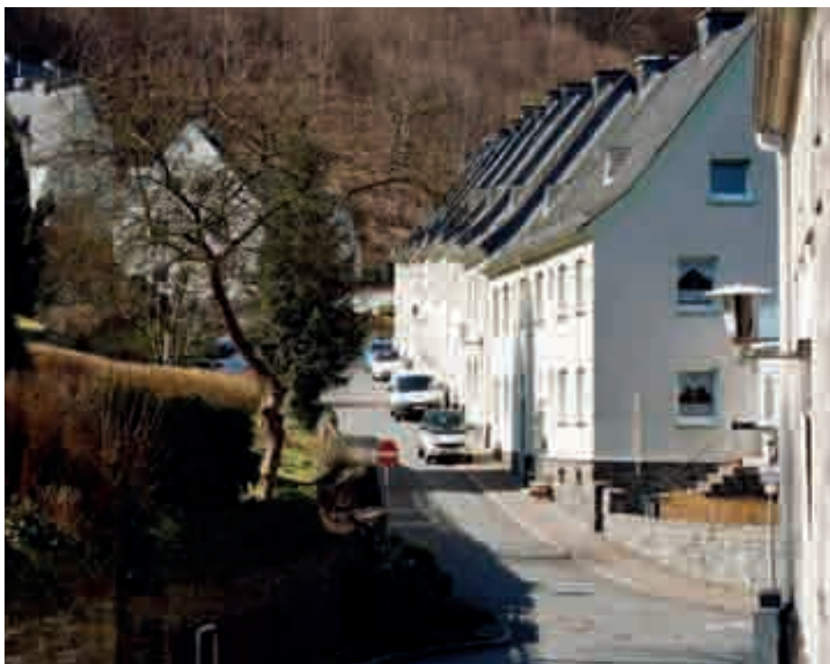
Die denkmalgeschützten Häuser Am Papenberg der ABG-Siedlung im Altenaer Stadtteil Knerling erhalten offene Glasfasernetze.
