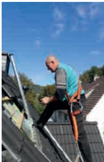
Über den Dächern von Altena. Ein Techniker installiert die Satellitenanlage.
