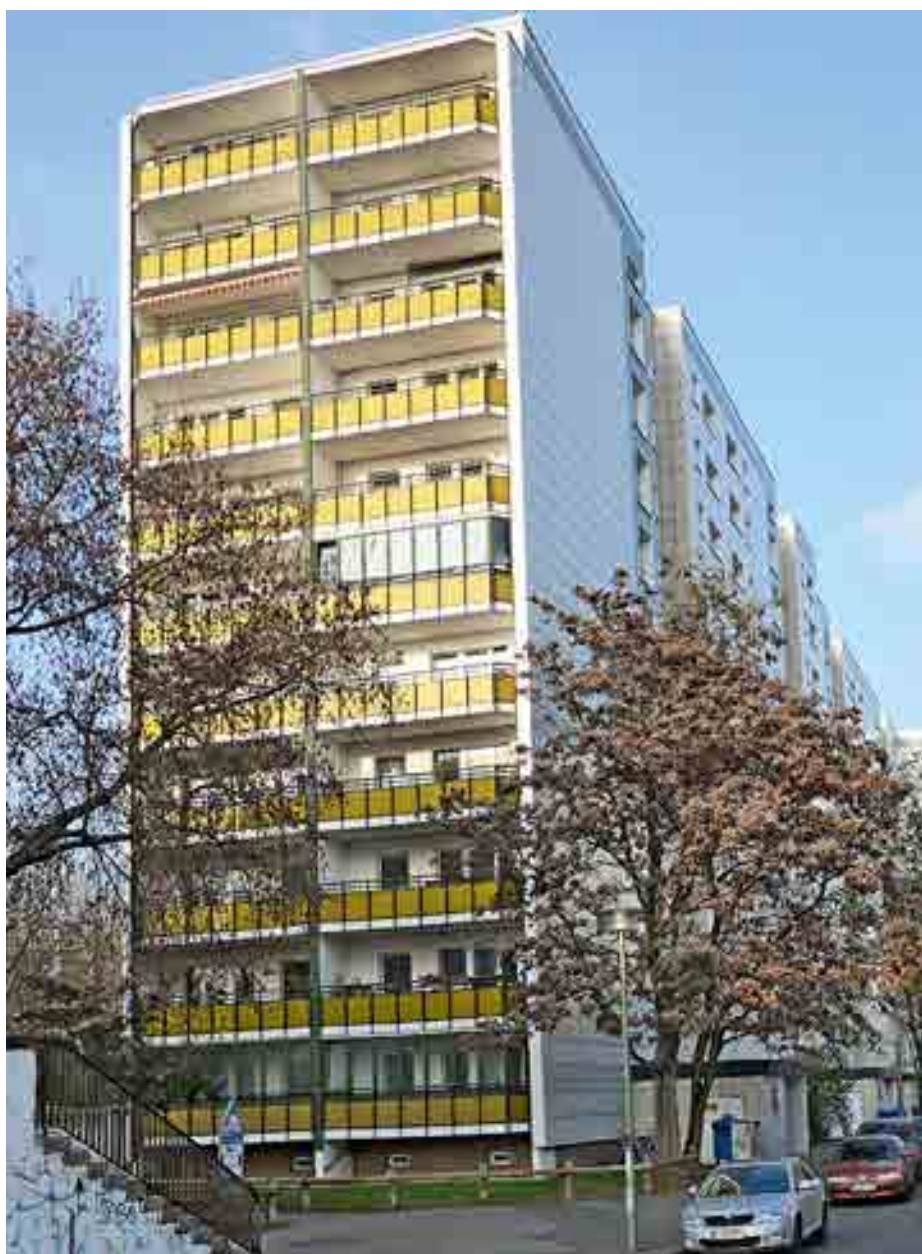
Wohngebäude der WGLi in der Paul-Junius-Straße
