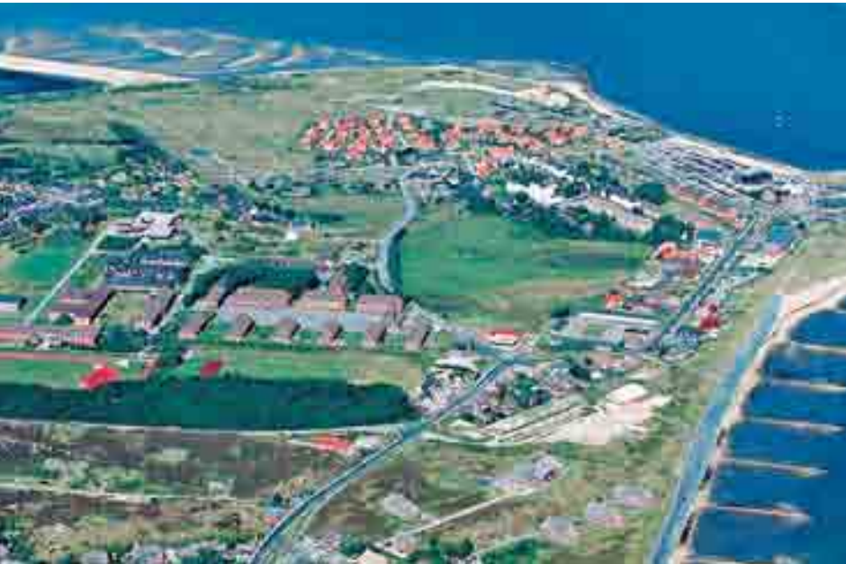
Auch das Areal in List, Nordfriesland, kann neu genutzt werden.
