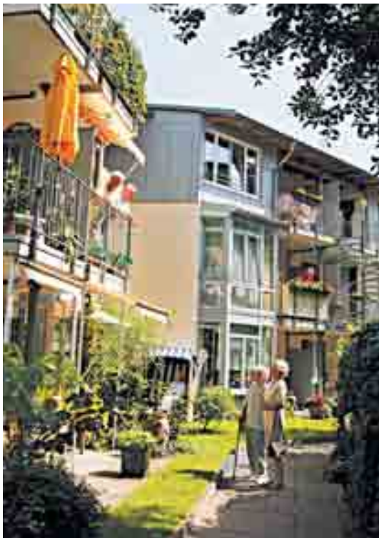
„Haus im Viertel“ der Bremer Heimstiftung: Kein Klassisches Pflegeheim mehr, stattdessen Stadtteilhäuser.
